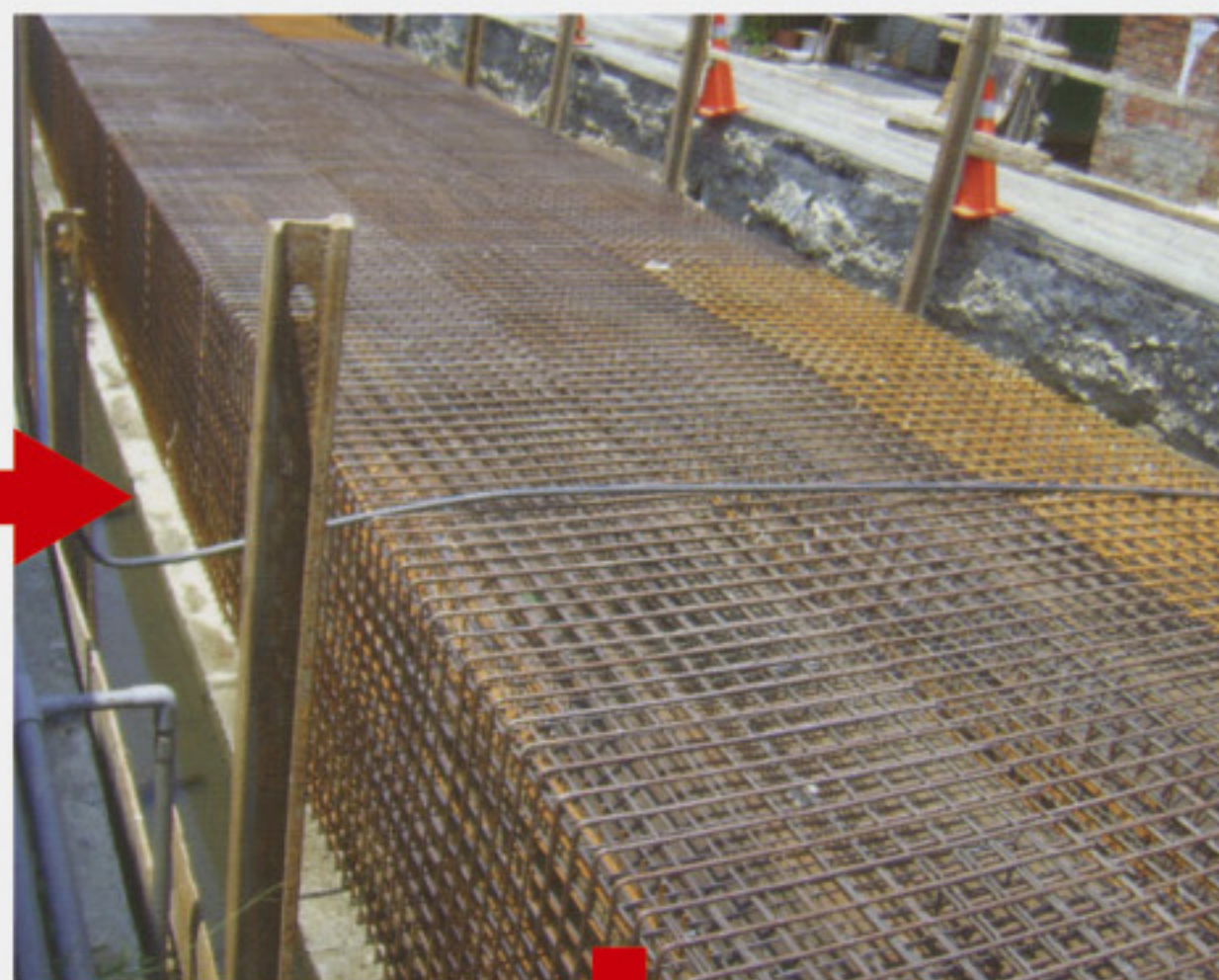
雙孔箱涵鋼網頂層
