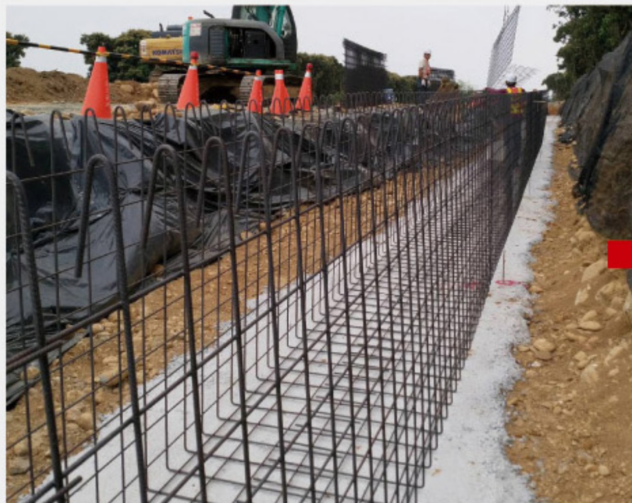
排水溝鋼網組立
