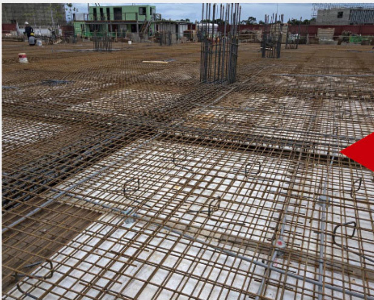
樓版鋼網上層鋪設
