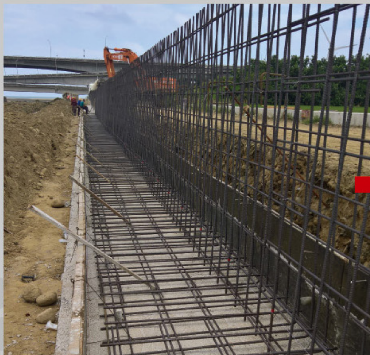
擋土牆鋼網組立
