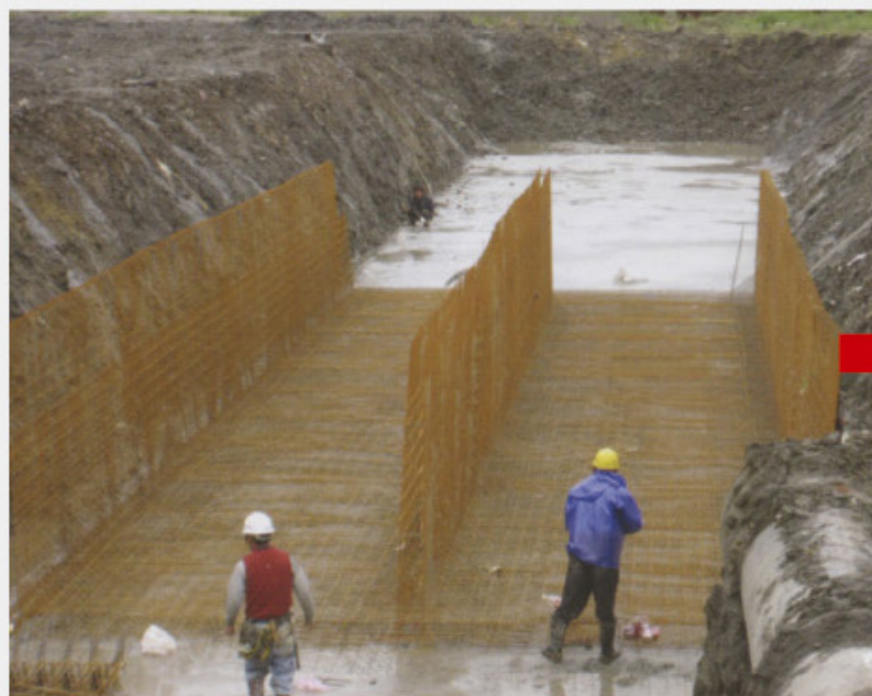
雙孔箱涵鋼網組立
