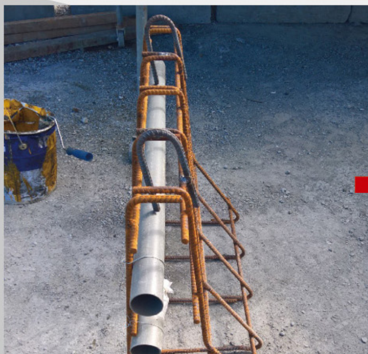
紐澤西護欄鋼網組立
