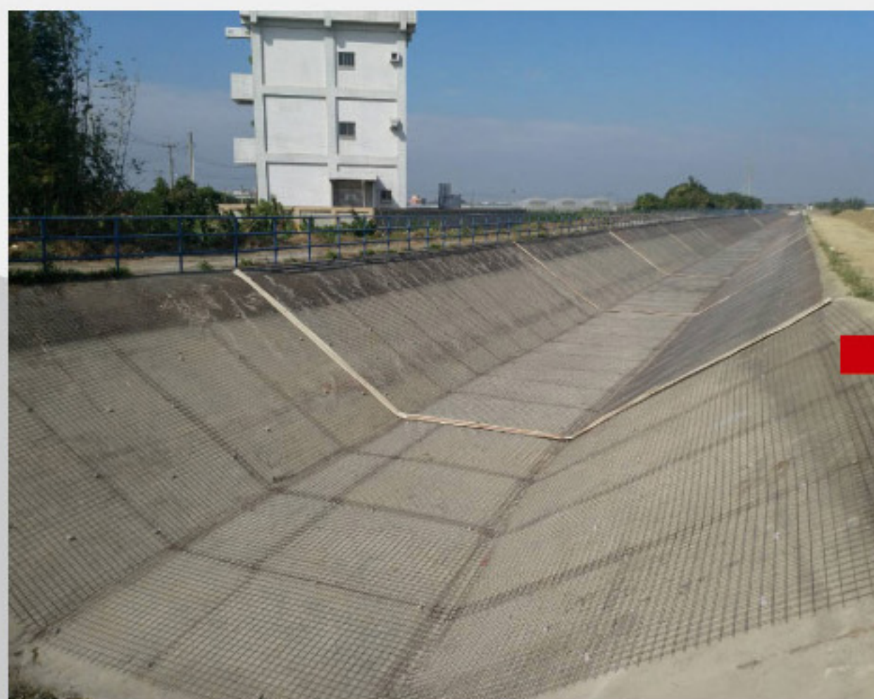
排水護岸鋼網鋪設
