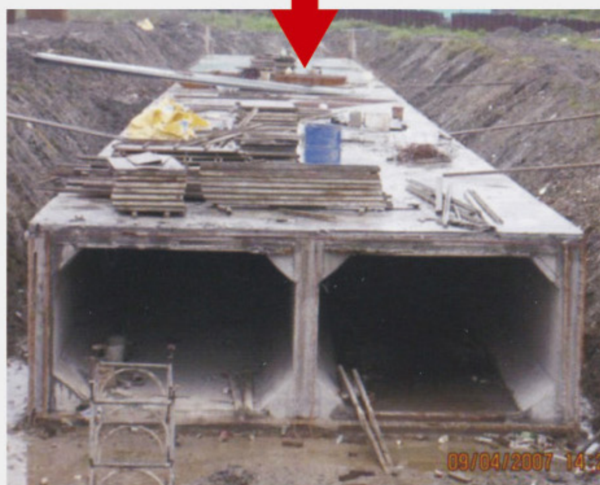
雙孔箱涵澆置完成
